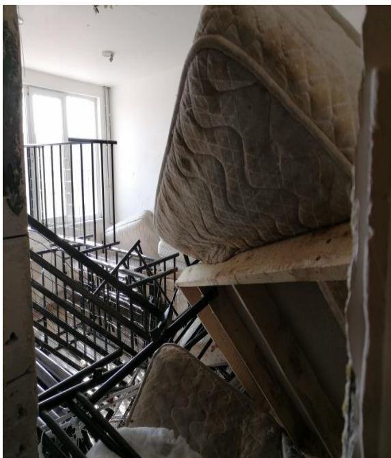
Ползваната за склад в Девето хале стая 27Б, с паднала каса, поради липса на крепежни елементи
